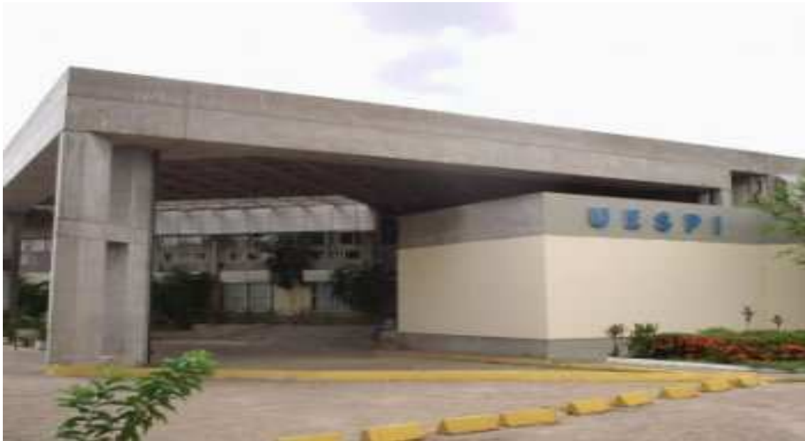
Figura1- Fachada do prédio da administração da UESPI Fonte- Arquivo pessoal
